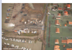
Opération de pompage : plusieurs brèches sont visibles au niveau de la digue à la Faute-sur-mer.
