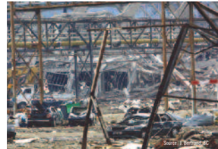
Dégâts occasionnés lors de l'explosion.
