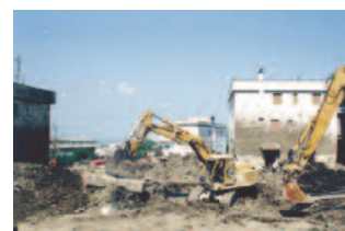
Déblaiement de la ville de Sarno.
