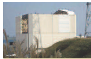
Toit du réacteur en cours de reconstruction.
