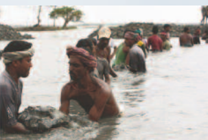
Reconstruction d'une digue au Bangladesh.
