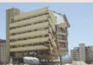
Dégâts sur un immeuble après le passage de la coulée de boue.
