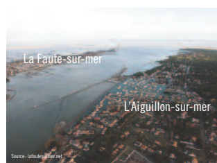
Inondation de La Faute-sur-mer et de L'Aiguillon-sur-mer.
