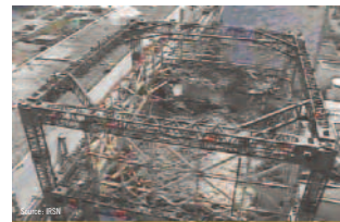
Toit du réacteur soufflé par une explosion.
