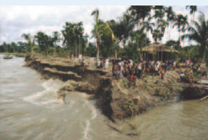
Érosion des berges du fleuve Brahmapoutre.
