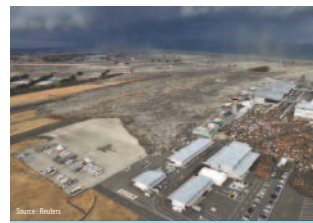
À plus de 2 km des côtes, l'aéroport de Sendai submergé.
