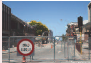
Fermeture du centre-ville pendant les travaux de reconstruction (janvier 2012).
