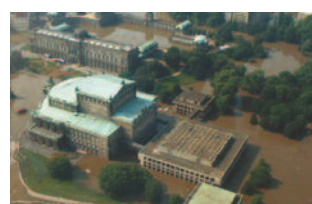
Inondation de l'Opéra Semper, Dresde 2002.
