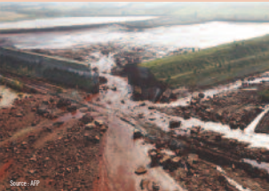
Brèche dans l'enceinte du réservoir.
