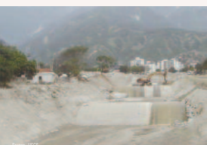
Réaménagement d'un canal afin d'améliorer l'évacuation des coulées de boue.
