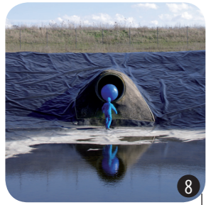
Bassins d'orage Puilboreau- France
