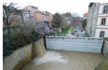
L'eau de la Garonne, en cas de crue, est susceptible de remonter dans les canalisations d'eaux pluviales et d'inonder ainsi des points bas de la ville. **Des vannes et des pompes** ont été installées pour éviter ce phénomène. Autant, de dispositifs à fermer et actionner au fur et à mesure de la montée des eaux.
